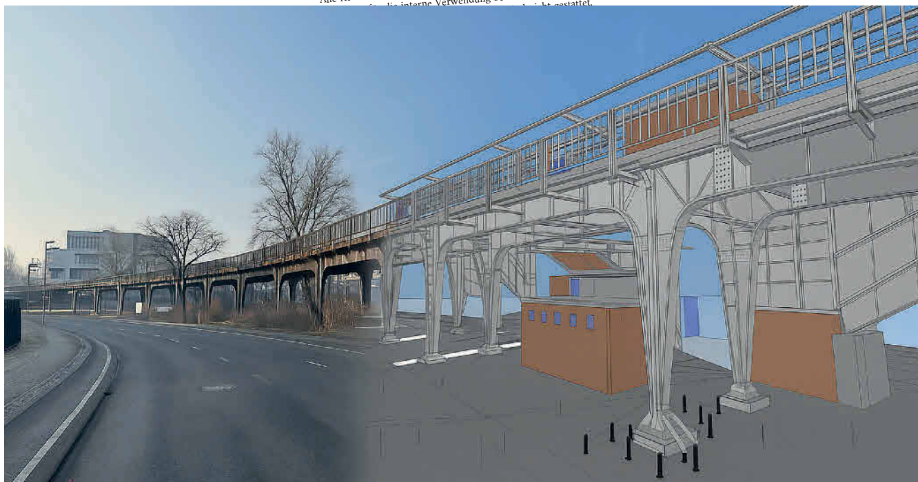
Die stillgelegte Siemensbahn soll bis 2029 reaktiviert werden. Foto: KREBS+KIEFER Ingenieure GmbH
