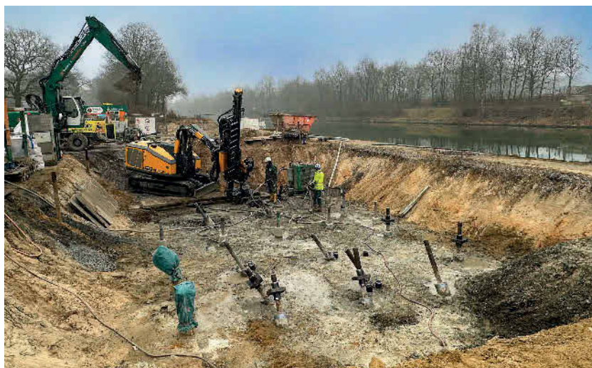
Die Widerlager der neuen Östricher Brücke wurden mit Mikropfählen in einem statisch optimierten Raster gegründet. Foto: FRIEDR. ISCHEBECK GmbH
