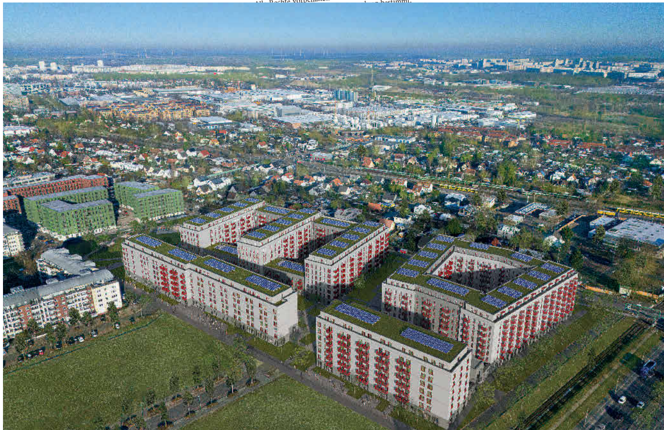
Großmaßstäbliche Wohnquartiere in modularer Bauweise zeigen, wie sich Nachhaltigkeit, Wirtschaftlichkeit und sozialer Wohnungsbau im innerstädtischen Kontext verbinden lassen. Foto: Thomas Hillig Architekten GmbH
