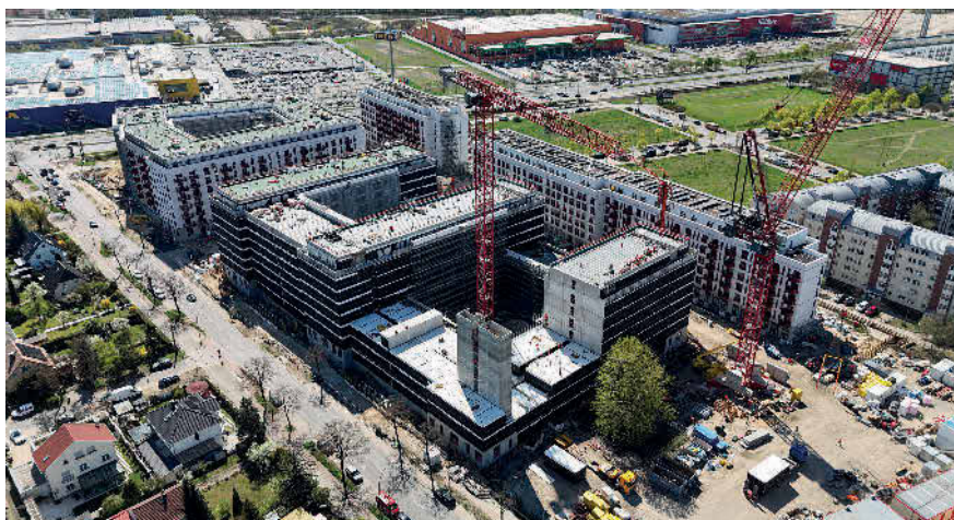
Industriell vorgefertigte Raummodule ermöglichen eine Verkürzung der Bauzeit und erhöhen Qualität sowie Planbarkeit im urbanen Wohnungsbau. Foto: Daiwa House Modular Europe GmbH_Dirk Enters
