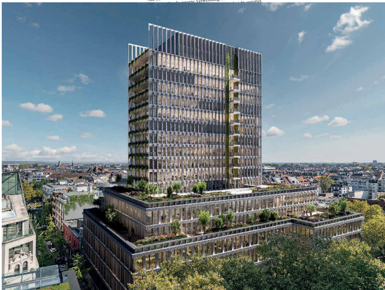
Der KöTower am südlichen Ende der Düsseldorfer Königsallee markiert mit 18 Geschossen und rund 71 Metern Höhe eine neue städtebauliche Landmarke. Foto: AVP Becker GmbH
