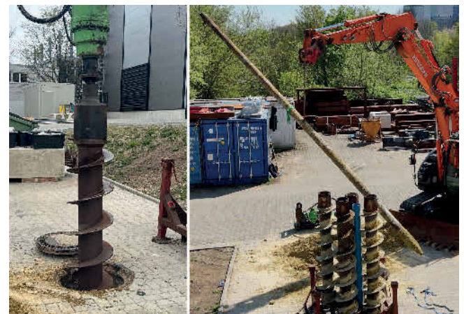
Bild 3. Rückbau mittels Freibohren (links: Bohrvorgang, rechts: Bergung) Foto: RWTH Aachen Fig. 3. Removal using open-hole drilling (left: drilling process, right: retrieval) Source: RWTH Aachen
