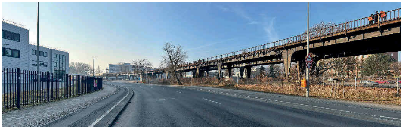
Das Mammutprojekt ist in drei Bauabschnitte unterteilt. Foto: KREBS+KIEFER Ingenieure GmbH
