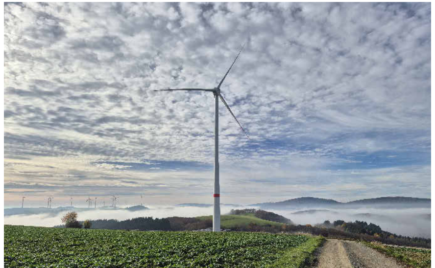
Stroth Telecom unterstützt das Windrad-Repowering im Nordpfälzer Bergland. Mit dort erzeugter Energie gleicht die Firma ihren Stromverbrauch und den seiner Kunden aus. Foto: wiwi consult
