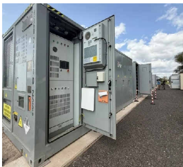
Blick ins Innere: Die Anlage von Tauber Energy basiert auf modularer Containerbauweise mit Lithium-Ionen-Technologie und wird über ein hochintelligentes Energie-Management-System gesteuert.
