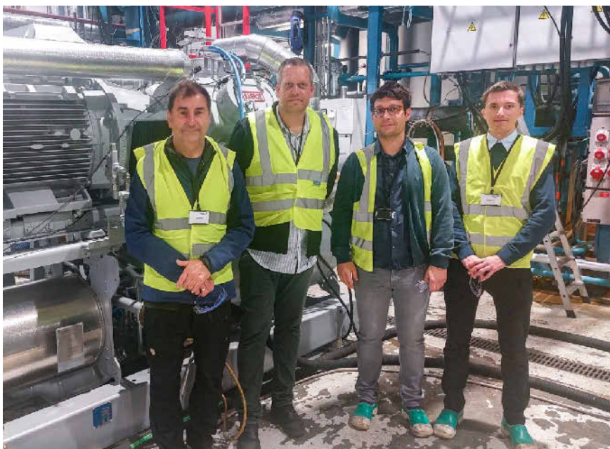
Vor der Wärmepumpe (v.l.n.r.): Steffen Härtelt, HSZG; Thomas Gubsch, HSZG; Felix Panitz, Fraunhofer IEG; Johann Meyer-Scheffel, HSZG. Foto: Fraunhofer IEG/Panitz
