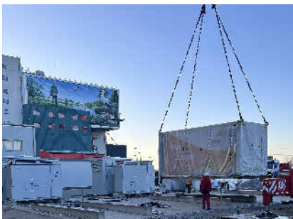
Einer der drei Container für den Stromspeicher in Premnitz in Brandenburg wird an den richtigen Platz gebracht. Foto: EEW energy from waste
