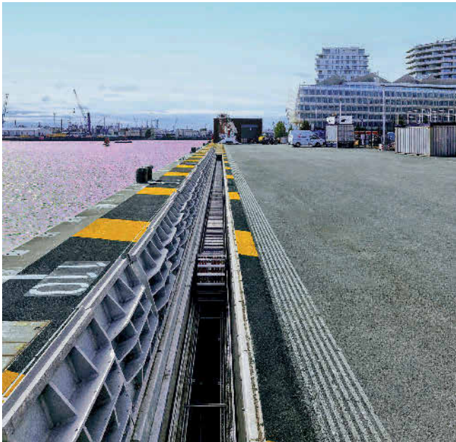
Bild 5 Energiekettensystem für Landstromanlagen. Foto: Tsubaki Kabelschlepp
